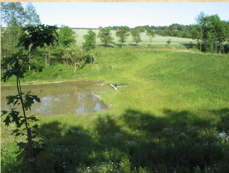
Nově vybudovaná stavba poldru na Končinském potoce. Stavba byla dokončena v roce 2004.
